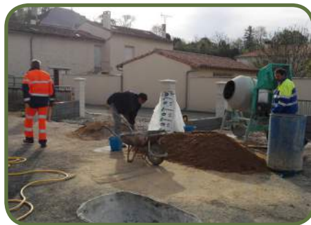
Travaux pour la création d'un parking au foyer rural
